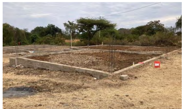
Abb. 5: Fundamente der zukünftigen Labors
